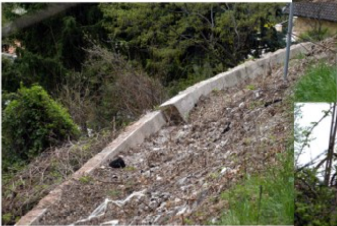
Immagini della rottura del muro che sostiene la strada
