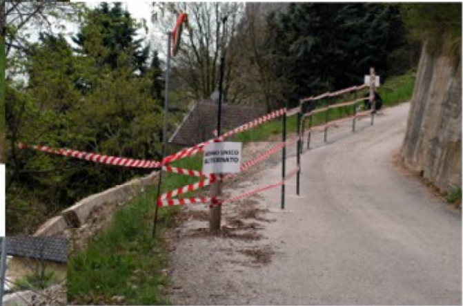
Immagini della rottura del muro che sostiene la strada
