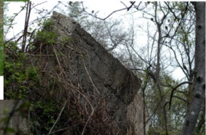
Immagini della rottura del muro che sostiene la strada
