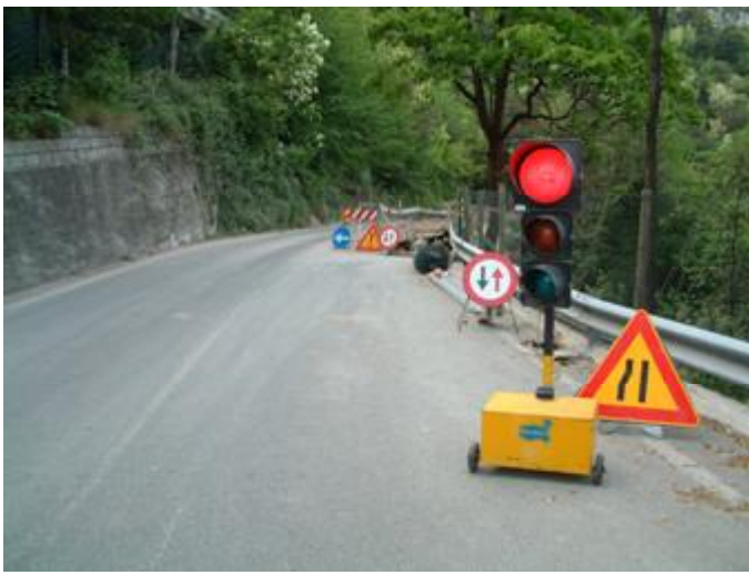
Lavori in corso in località Bassanega per la ricostruzione della strada provinciale SP38 crollata alcuni giorni fa. E' previsto il senso unico alternato regolato da semaforo.
